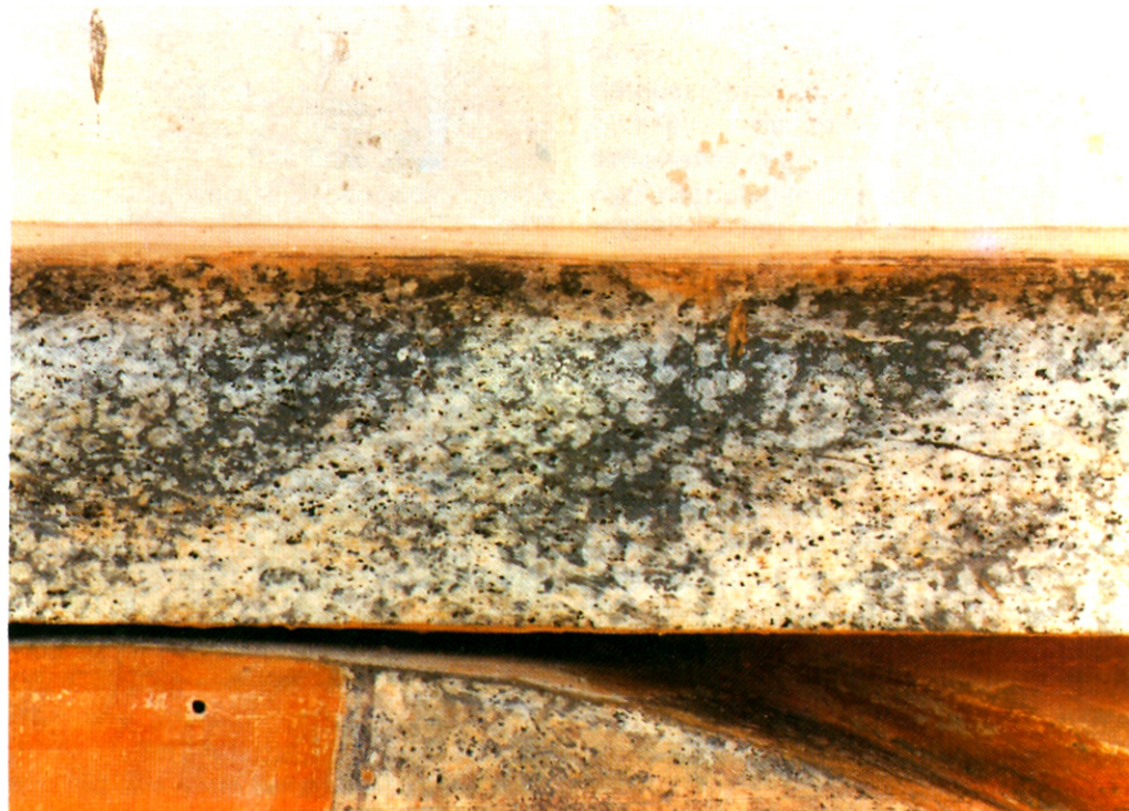
Detail der grau marmorierten Fenstereinfassung vor der Restaurierung
